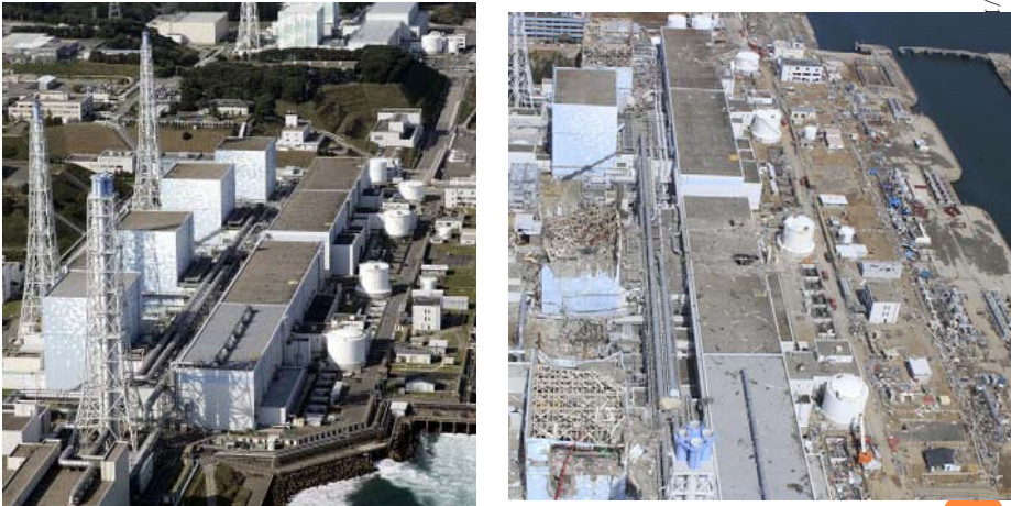
奥から順に1号機・2号機・3号機・4号機
